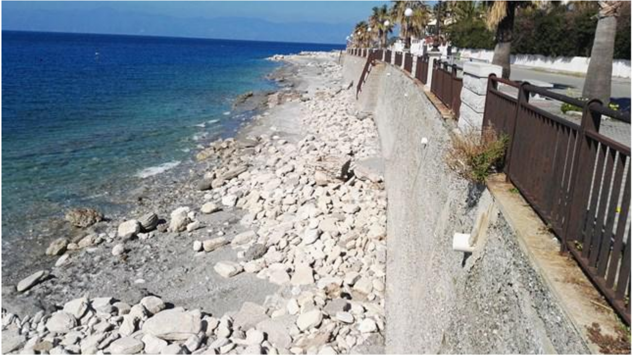
Figura 9 Foto 5 Inizio lato Sud Lungomare Cicerone zona A Lazzaro
